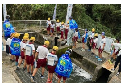
飯盛野疏水2号分水工
