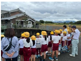
六ヶ井円筒分水工(小野市)
