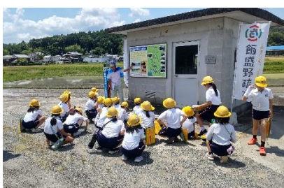
飯盛野疏水取水口
