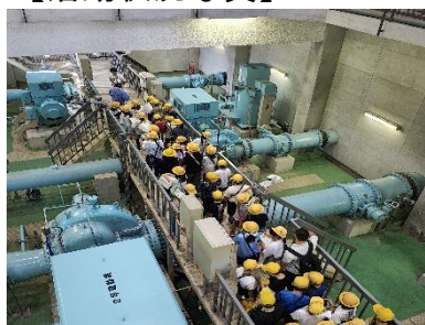
杉原川揚水機場①
