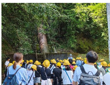
杉原川揚水機場②
