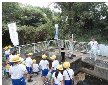
飯盛野疏水2号分水工
