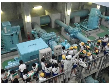
杉原川揚水機場①
