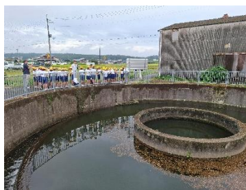
六ヶ井堰円筒分水
